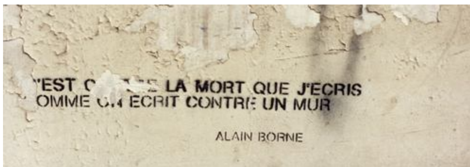
Mur du XI e (vous devinerez les mots entre les écaillures)
