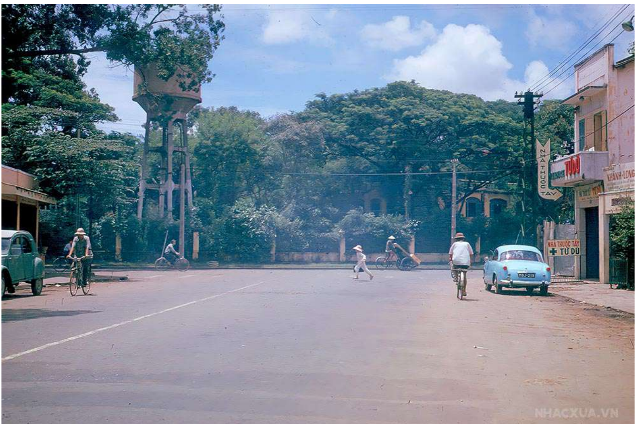
Đường Bùi Thị Xuân, đoạn ra ngã ba với đường Cống Quỳnh. Xe xích lô đang đi về phía Bệnh
